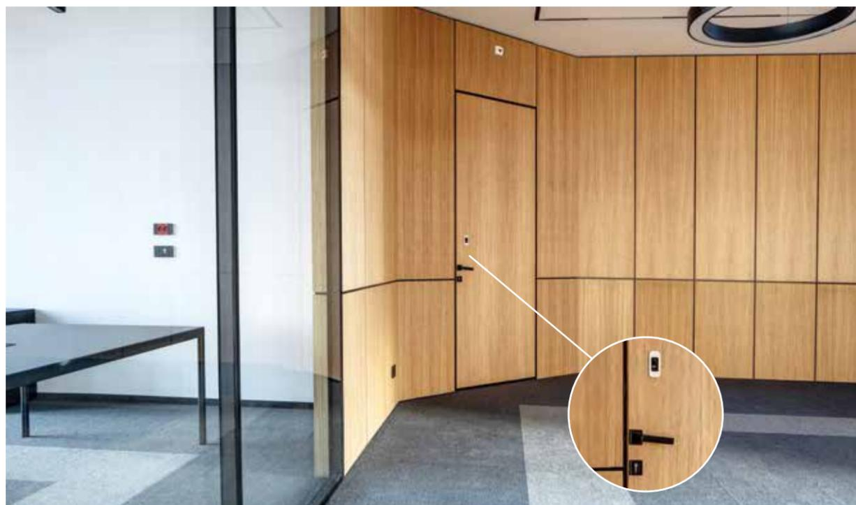
**PANNELLO ANTA IN LEGNO** realizzata in pannello sandwich spessore 78 mm con struttura impiallacciata con inserto in metallo, pannelli in legno e isolamento. La struttura è realizzata in legno massello di spessore 78 mm. La battuta dell'anta è allineata al telaio della porta. C'è una possibilità per il rivestimento decorativo.
