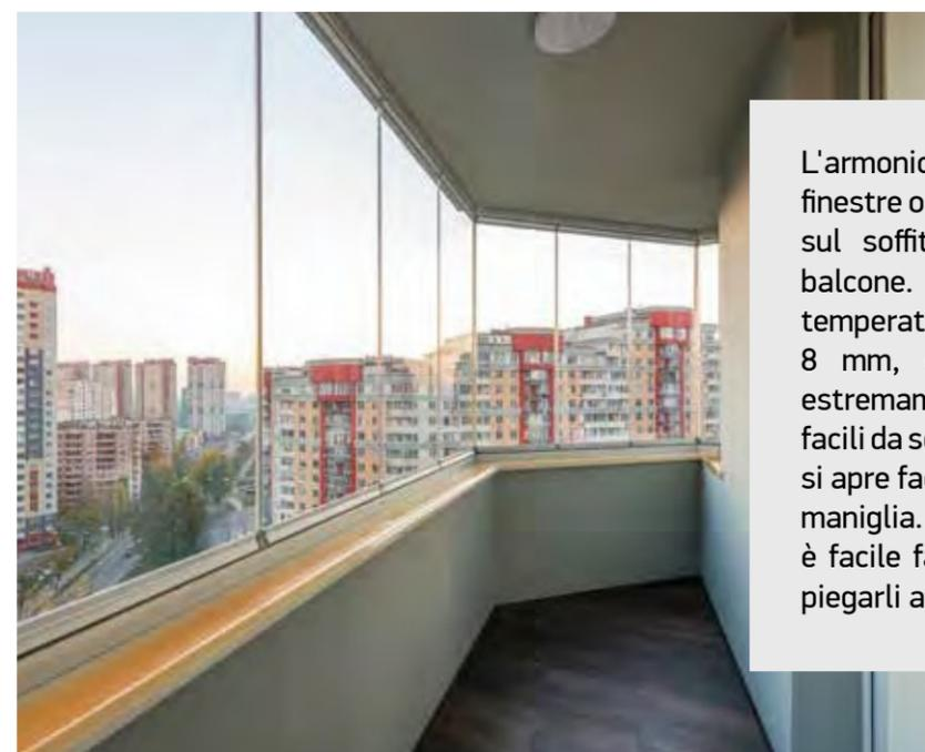
L'armonica di vetro è costituita da due finestre orizzontali in alluminio montate sul soffitto, ringhiere pavimento del balcone. Al telaio si monta in vetro temperato. Questo vetro di spessore 8 mm, obbligatoriamente temperato, estremamente resistente, ma molto facili da scorrere e piegare. Il primo vetro si apre facilmente da solo sollevando la maniglia. Dopo che il primo è aperto, è facile far scorrere gli altri pannelli e piegarli al muro.
